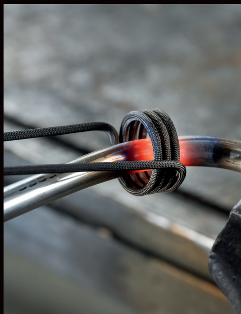
使用加热线圈加热管道, 以便后续弯曲
