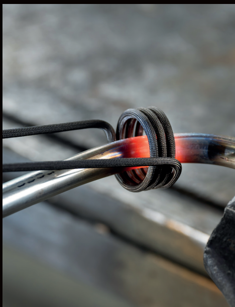
Verwarmen van een buis met een verwarmingsspiraal, om het daarna te kunnen buigen.
