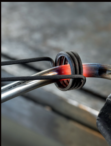
Opvarmning af et rør med en opvarmningsspole for derefter at kunne bøje det
